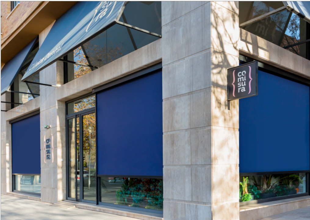
Instalación de Wind Screen en clínica dental.
