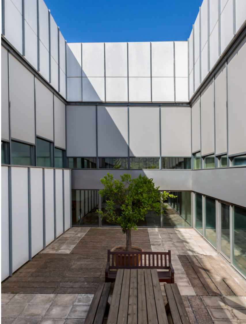
Instalación de Wind Screen en el Parque de las Ciencias, Granada.
