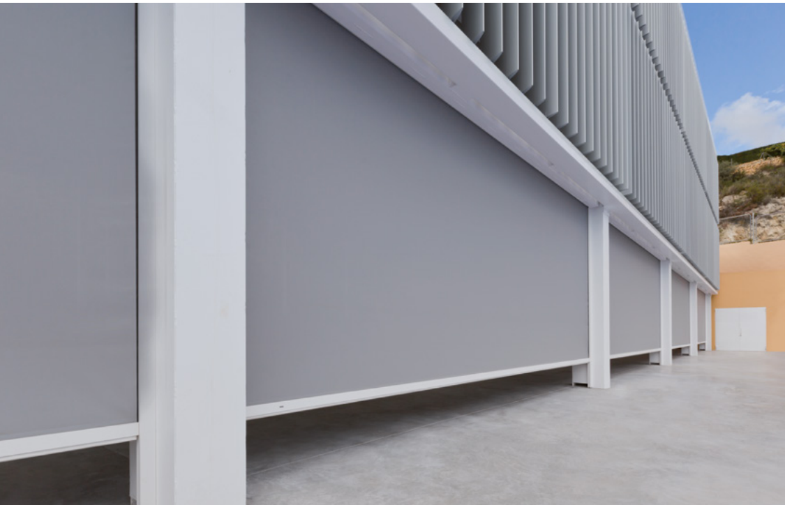
Instalación de Wind Screen en Centro Privado de Enseñanza Almeida, Callosa de Ensarriá (Alicante).
