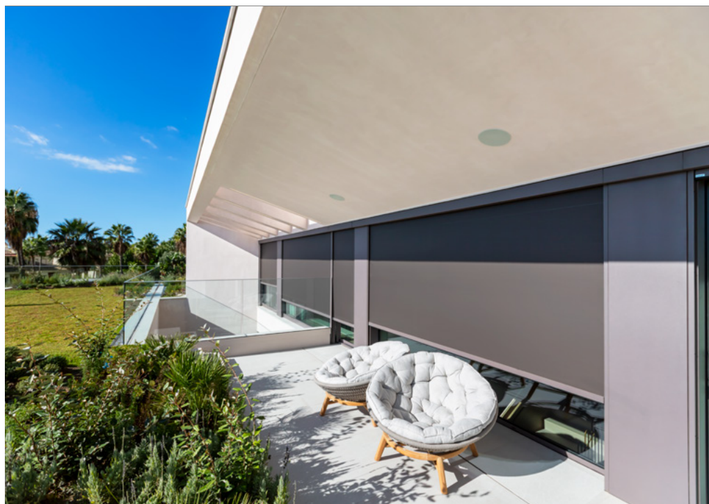
Instalación de Wind Screen en vivienda privada.
